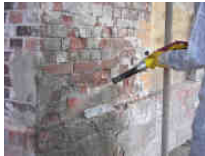
Feuchtstrahlkopf im Einsatz
