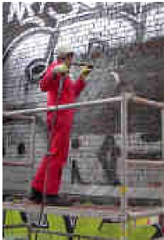
Abstrahlen mit Heißwasser-Hochdruck
