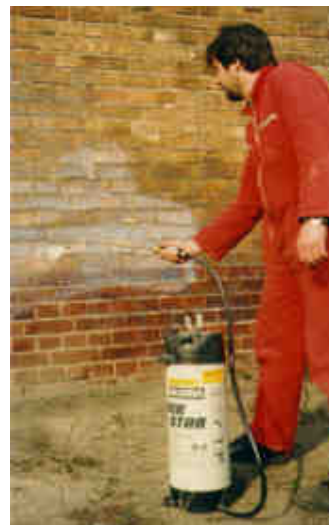
Auftragen von MEOS Farbabweiser
