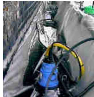
Folienbecken mit flachabsaugender Tauchpumpe
