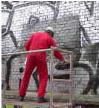
Aufbringen des Gels mit dem Quast
