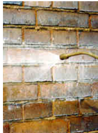
Auftragen von MEOS Farbabweiser
